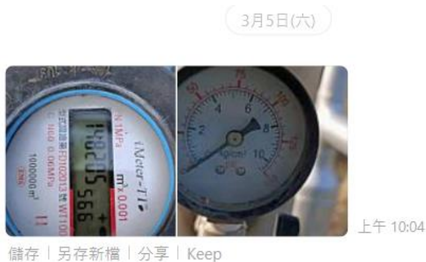
圖 2. 停水期間自來水進水壓力錶及水錶
